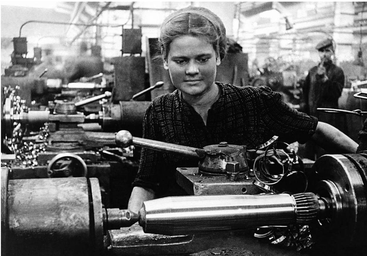
Фотография 3. Оборонный завод. Стахановка М.И. Кириличенко за расточкой корпуса снаряда<sup>230</sup>
