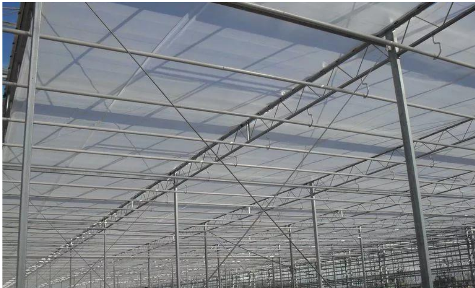
Рисунок 17 - Система зашторивания. (фото Павел Ворожцов).
