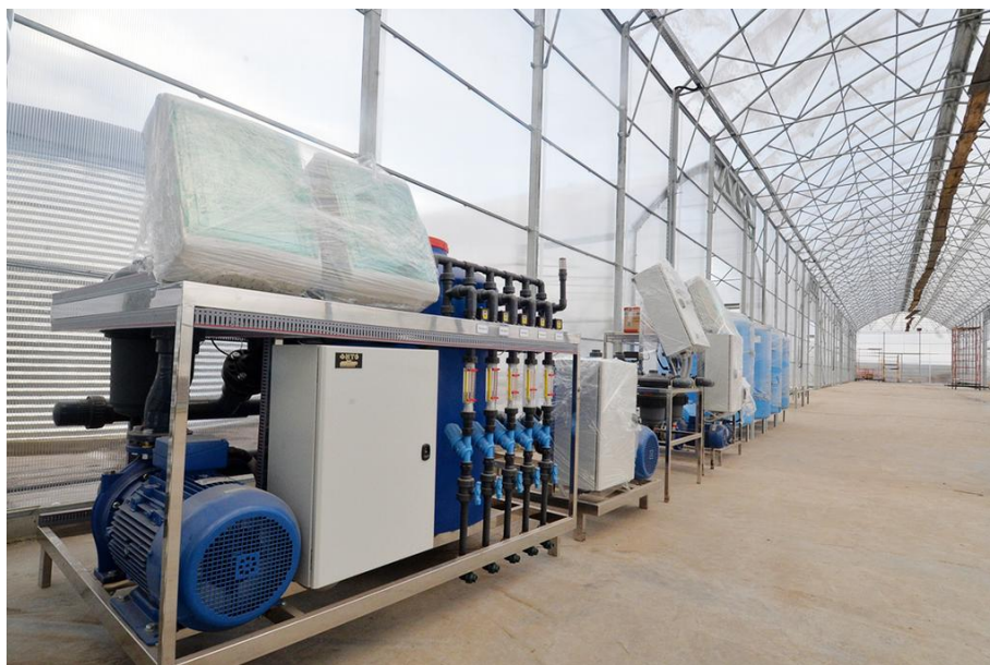
Рисунок 18 - Система капельного полива (фото Павел Ворожцов)
