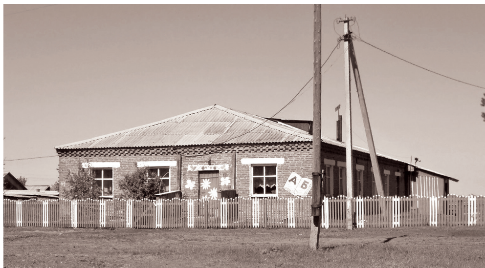
Рис. 19. Здание Чернаковской школы первой ступени Новосибирской области
