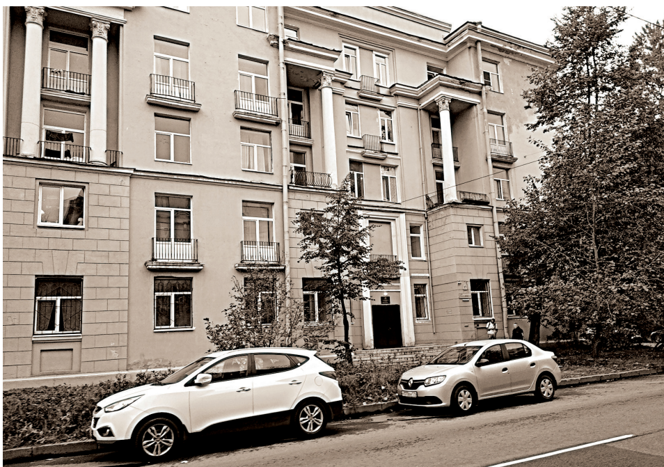
Рис. 31. Фото здания общежития № 1 Гидрометеорологического института, Санкт-Петербург, ул. Стахановцев, 17
