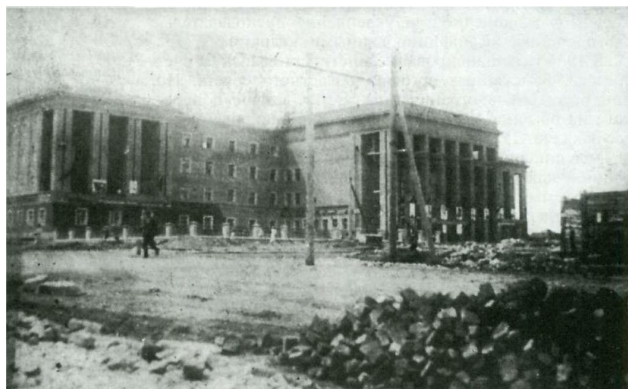
Строительство главного корпуса, 1936 г.
