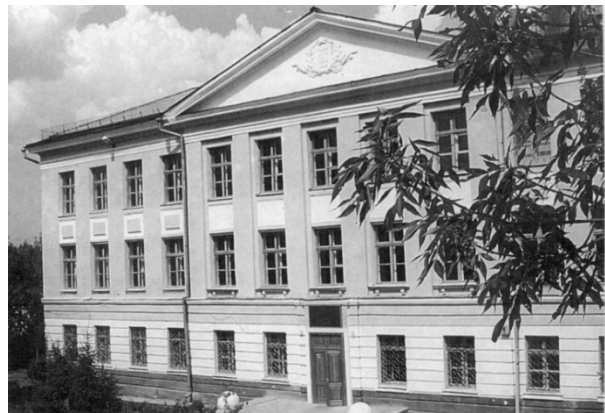
Здание представительства ЧГПУ в г. Миасс.
