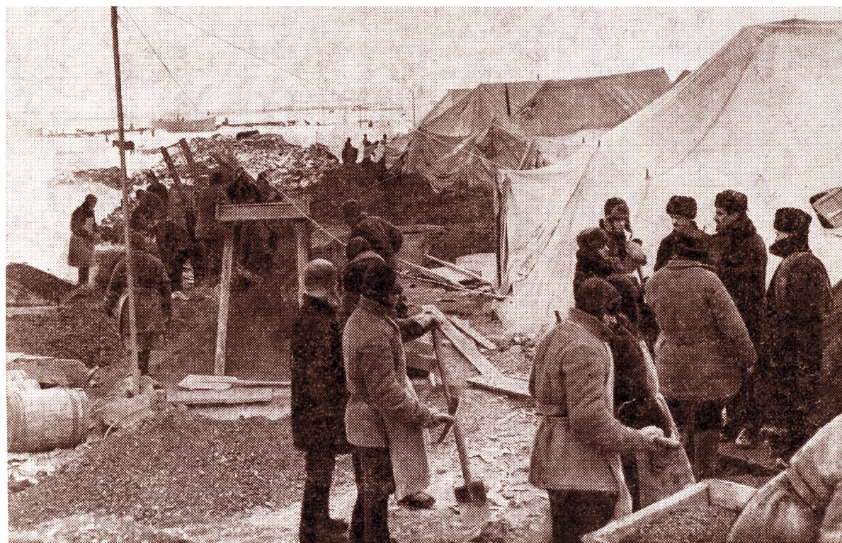
Закладка фундамента ММК
