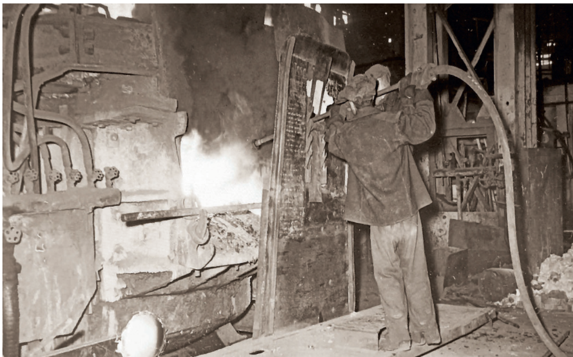
Сталевар электросталеплавильного цеха Златоустовского металлургического завода Н. Ф. Клопов и его подручный А. Н. Носков во время подачи кислорода в электросталеплавильную печь. 1956. — ОГАЧО. Ф. Р-2012. Оп. 3. Д. 956. Л. 1
