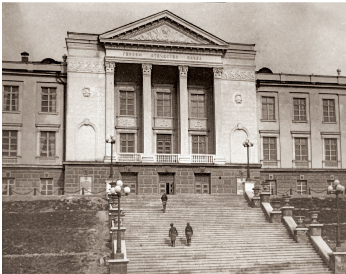
Дворец культуры машиностроительного завода. 1948 г. — ОГАЧО. Ф. Р-2012. Оп. 3. Д. 2719. Л. 1
