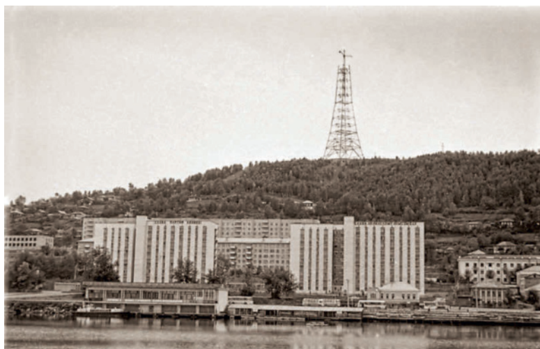
Строительство ретрансляционной телевизионной станции. Начало 1980-х гг. — Личный фотоархив автора
