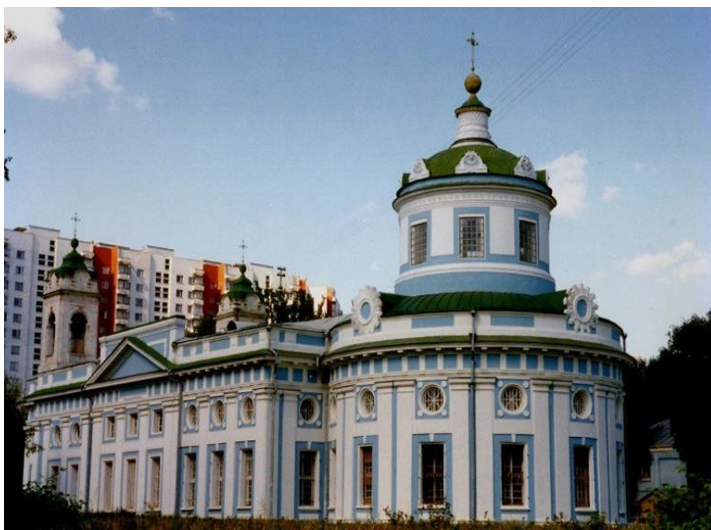
Рис. 13. Храм в честь духа святого Лазаря на кладбище в Марьиной роще Архитектор Д.В. Ухтомский. Москва
