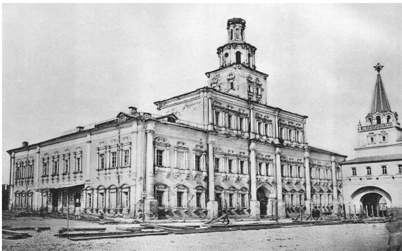
Рис. 11. Здание Московского университета Архитектор Д.В. Ухтомский
