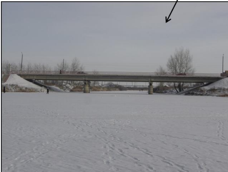
Снимок 5. Участок реки Синташта в пределах зоны сужения при строительстве моста (пос. Бреды)
