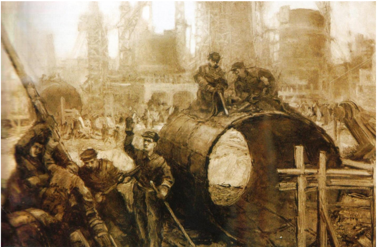
Георгий Соловьев «Строительство домны» 225 (1938 г.)
