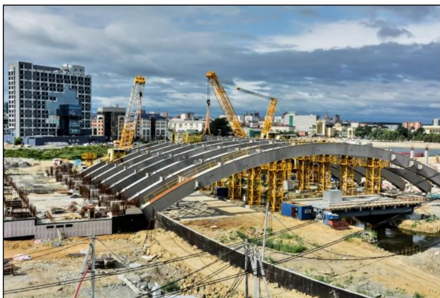
Рисунок 9 – Строительство Конгресс-холла на реке Миасс в пределах г. Челябинск [37]
