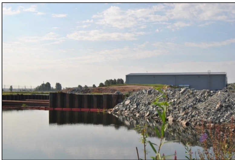
Рисунок 11 – Водозаборное сооружение на реке Миасс (фото автора)
