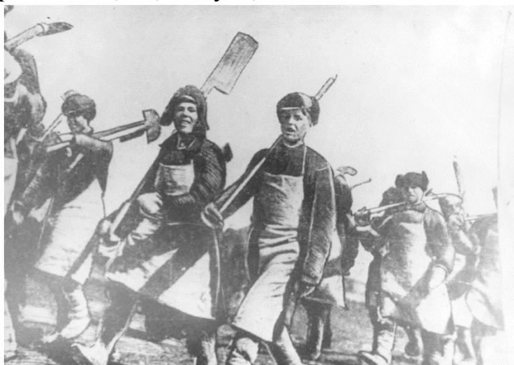
27 июня отдано было распоряжение выкопать котлован под этот дом. 400 землекопов и коновозчиков-грабарей работали в три смены, днем и ночью. Такими же темпами возводили и стены. Даже сегодня, когда на каждой стройке десятки различных машин, это кажется невероятным. А тогда главным орудием строителей были лопаты и мастерок, а кирпич переносили в специальных деревянных козлах на спине.
