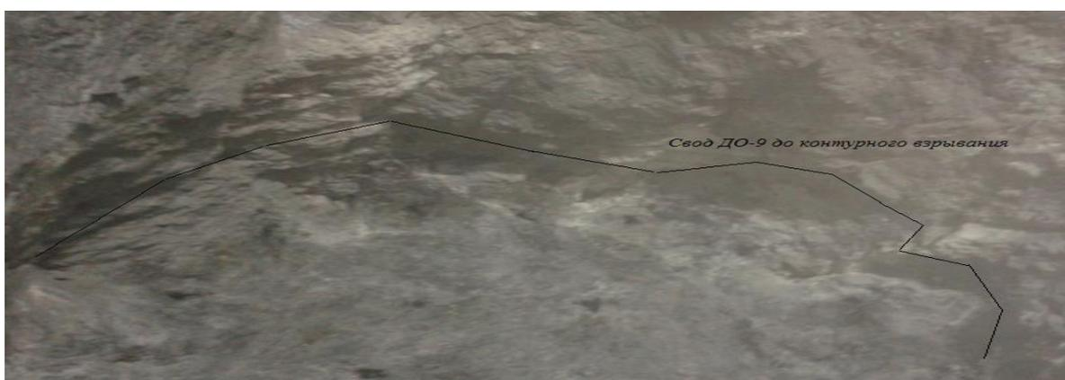
Рис.3 Вид кровли ДО-9 при взрывании забоя обычным способом
