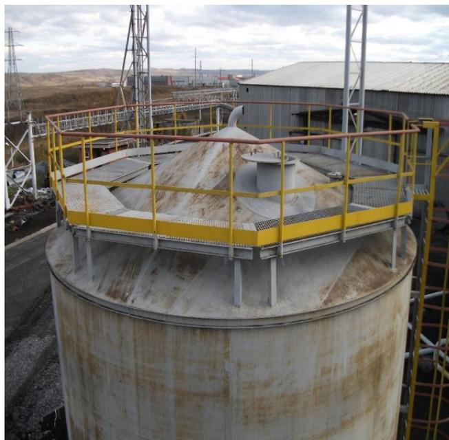
**Рис. 9.1.4. Площадка, покрытие, стены и ограждение противопожарного резервуара №3**
