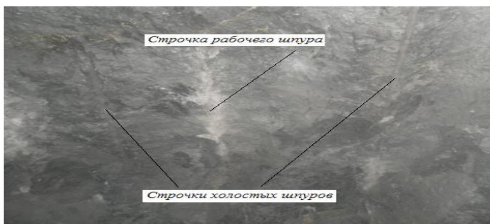
Рис.2 Вид кровли БШК-1 после контурного взрывания
