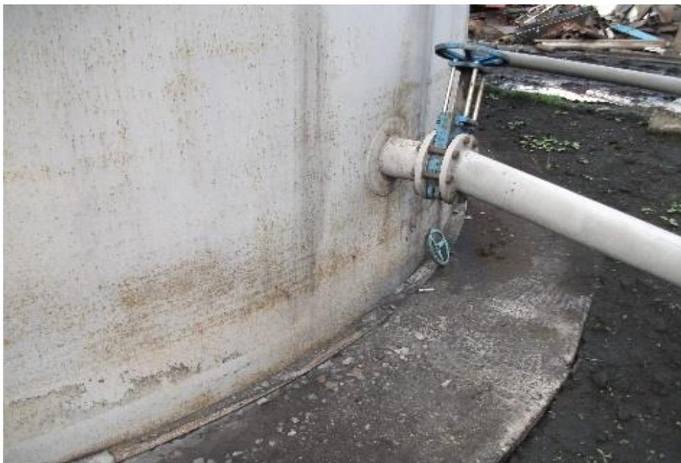
Рис. 9.1.1. Стык противопожарного резервуара №2 и подающего трубопровода холодной воды Ø 150
