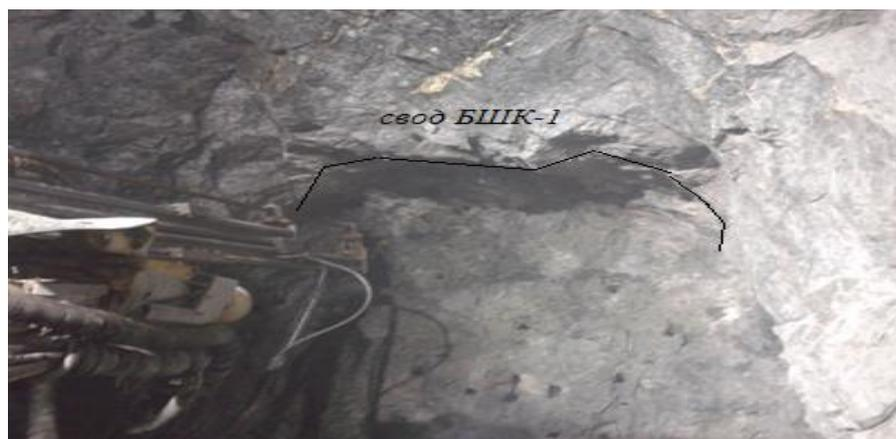
Рис.1 Вид кровли БШК-1 при взрывании забоя обычным способом (отмечено интенсивное заколообразование)
