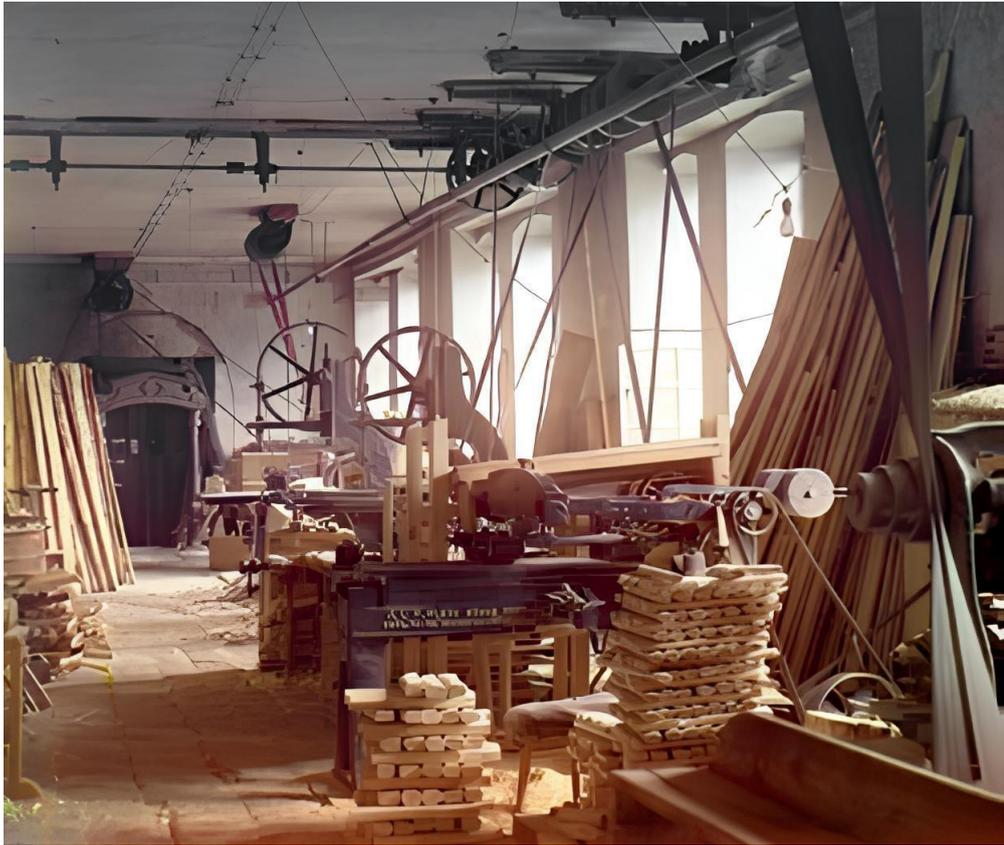
Рисунок 16 – фотография С.М. Прокудина-Горского «Столярный цех для выделки ножен на Златоустовской оружейной фабрике, 1909 г. [35, с. 99]
