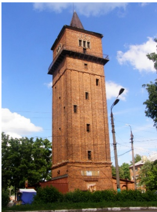
Рисунок 6 – Водонапорная башня, Кимовск
