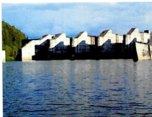
Рисунок 5 – Заброшенная плотина Верхнеарслановского водохранилища [16]
