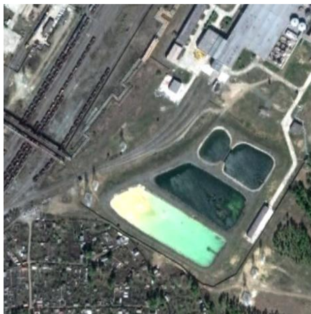
Рис.10 . Шламонакопители на территории ТЭЦ-3.
