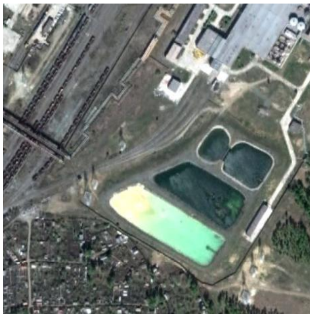
Рис.11. Шламонакопители на территории ТЭЦ-3
