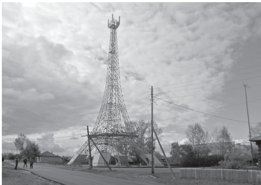
Илл. 25. Южноуральская «Эйфелева башня». Челябинская область, Нагайбакский район, село Париж 2012 г.
