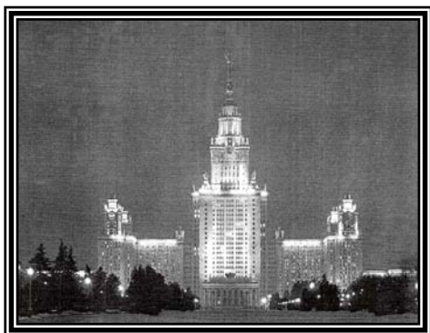
Новое здание МГУ на Воробьевых горах (постройка 1955 года)
