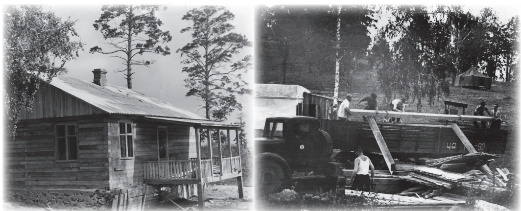
Строительство первых корпусов
