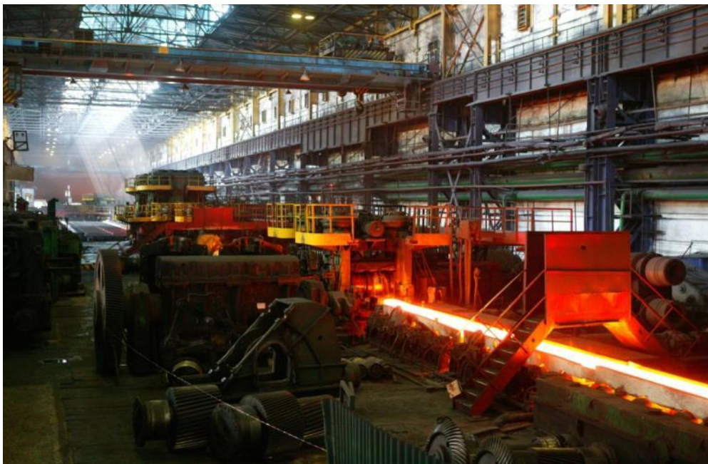
Рис. 3.18. Вид станového пролета НЗС со стороны блюминга
