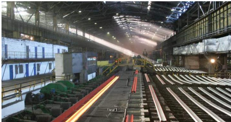
Рис. 4.27. Вид цепных холодильников
