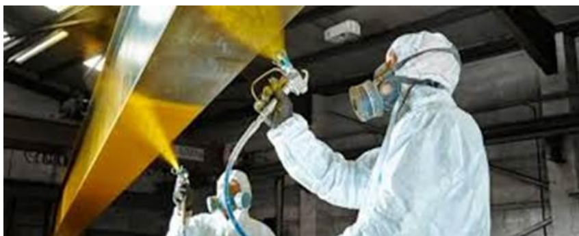
Рисунок 5.3 – Нанесение защитного слоя на конструкцию
