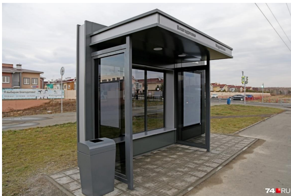
Рисунок 15 – Остановки, установленные на остановочных пунктах в 2019-2022 гг. и имеющие ряд конструкционных недостатков (фото – 74.ру)
