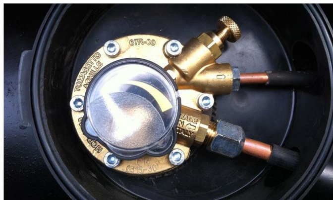
Рис.2. 5. – Монтаж мультиклапана на цилиндрическом боллоне
